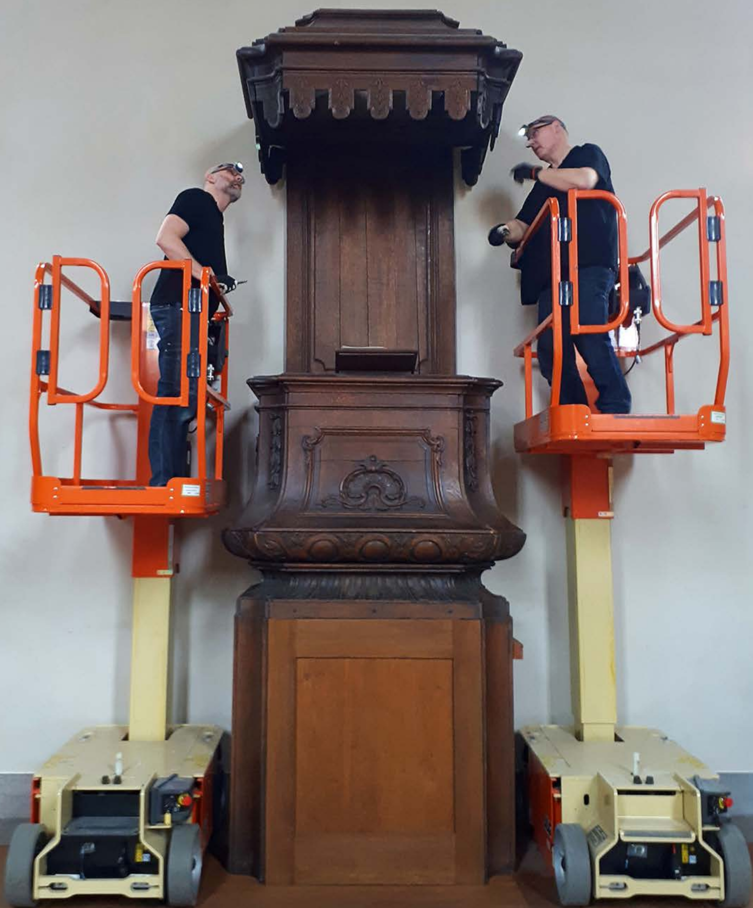
Barockhallens predikstol förbereds för nedmontering.
